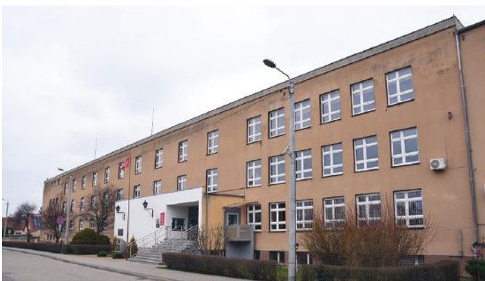
W Zespole Szkół Ponadpodstawowych im. Franciszka Ratajczaka w Kościanie planowany jest m.in. remont kotłowni i wymiana kotłów grzewczych.
