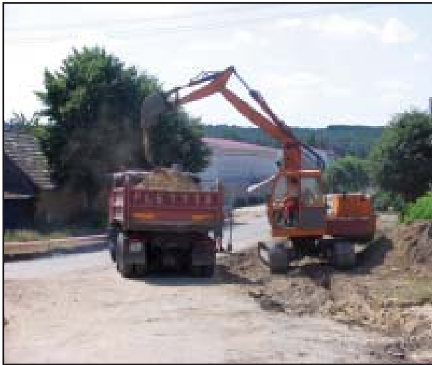
Droga w Lubiniu będzie miała nową nawierzchnię.
