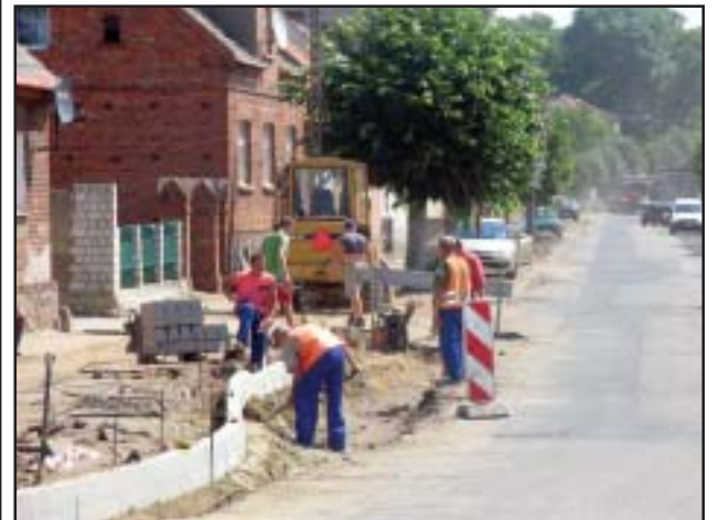
Po obu stronach drogi powstaną chodniki i ciągi pieszo-rowerowe
