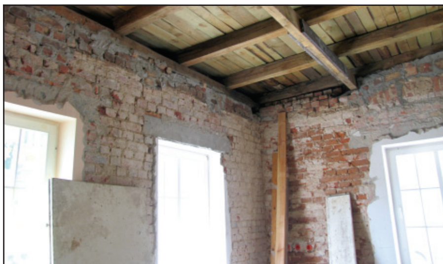
W dobudowanym magazynie będą dwa pomieszczenia.
