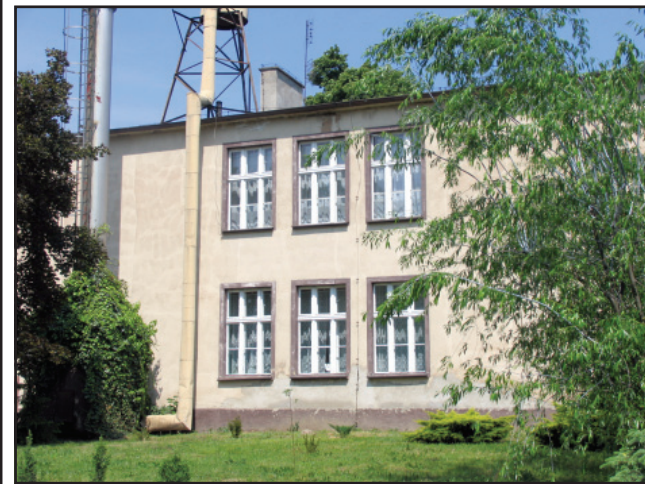
W budynku „B” szkoły w Nietążkowie zostaną wymienione 32 okna.
