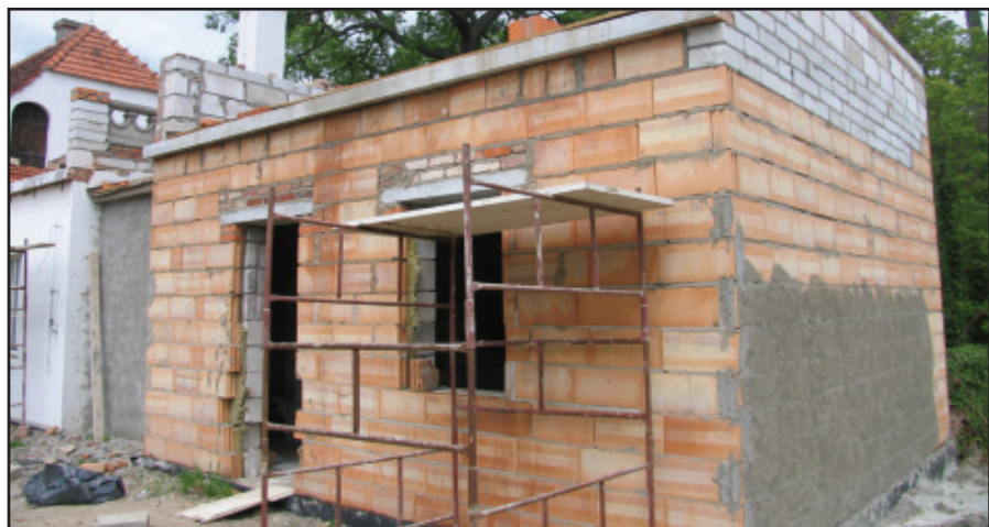
Po generalnym remoncie w domku ogrodnika będzie kuchnia.
