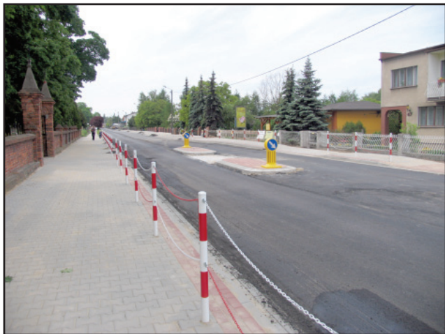
Wzdłuż ulicy wyremontowano chodniki.
