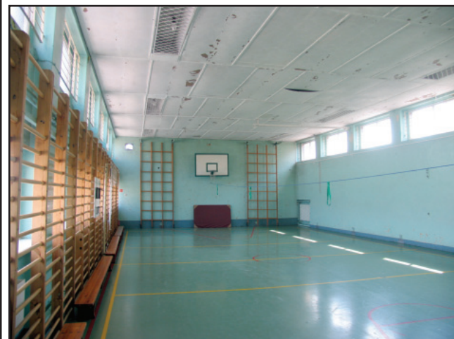
W sali sportowej Zespołu Szkół Ponadgimnazjalnych w Kościanie będzie generalny remont.
