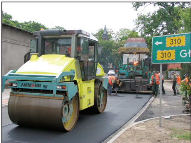
Na długości 4 km położono nową nawierzchnię.
