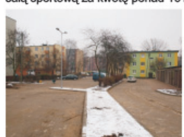
Parking na osiedlu Piastowskim - o powierzchni 1800 m 2 z 38 miejscami parkingowymi wykonany z kostki betonowej wraz z oświetleniem
