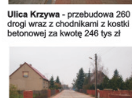
Ulica Krzywa - przebudowa 260 mb drogi wraz z chodnikami z kostki betonowej za kwotę 246 tys zł
