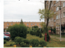
Osiedle Jagiellońskie - przebudowa oświetlenia parkowego, montaż 110 energooszczędnych lamp za kwotę 270 tys zł
