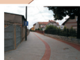
Ulica Kątna - przebudowa drogi na ciąg pieszo-jezdni z kostki betonowej o długości 130 mb za kwotę 94 tys zł
