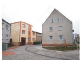
Ulica Mikołaja Reja - wykonanie 102 mb jezdni i chodników z kostki betonowej za kwotę 112 tys zł
