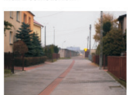
Ulica 2-go Października - budowa 92 mb drogi i chodników z kostki betonowej wraz z kanalizacją deszczową za kwotę 91,5 tys zł
