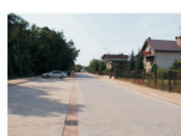
Ulica Dąbrowskiego - przebudowa 424 mb jezdni z kostki betonowej z chodnikami i kanalizacją deszczową, nowym parkingiem przy cmentarzu za kwotę 712 tys zł
