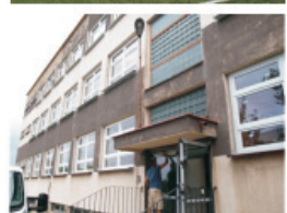
Termomodernizacja ZS nr 3 - wymiana stolarki okiennej i drzwiowej w budynku B i C za kwotę ponad 230 tys zł Remont dachu nad dwoma sektorami łącznikami oraz salą sportową za kwotę ponad 161 tys zł
