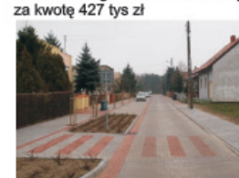
Ulica Nowowiejskiego - przebudowa 430 mb drogi i chodników po obu stronach drogi z kostki betonowej za kwotę 427 tys zł
