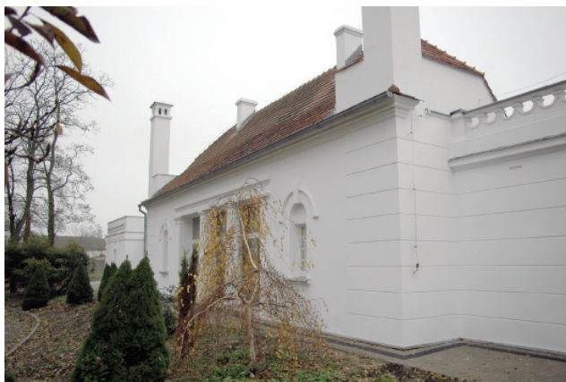
Na budynku kuchni w DPS w Jarogniewicach zostanie wyremontowany dach.
