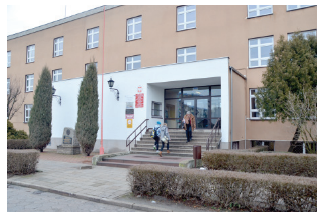
W Zespole Szkół Ponadgimnazjalnych w Kościanie zostaną przebudowane schody i będzie zamontowany podnośnik dla osób niepełnosprawnych.
