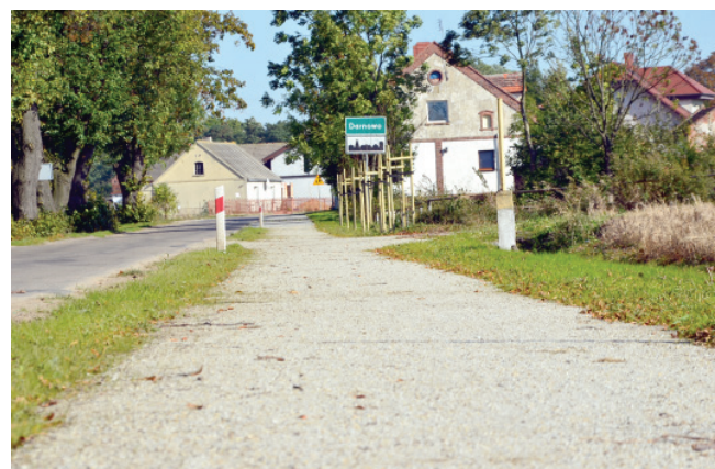
Będzie kontynuowany program budowy ścieżek rowerowych. Nowa trasa powstanie m.in. w Darnowie.
