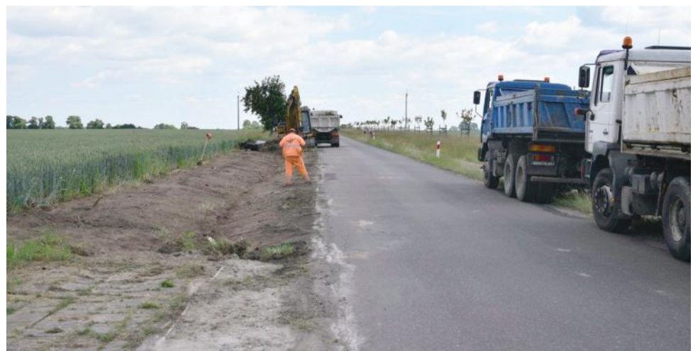
Prace na drodze już się rozpoczęły.
