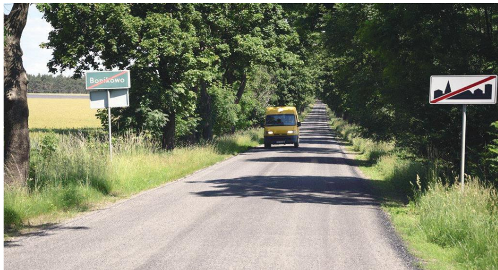
Droga została utrwalona powierzchnio na odcinku blisko 3 km
