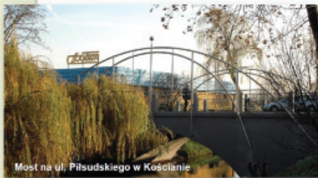
Most na ul. Piłsudskiego w Kościanie
