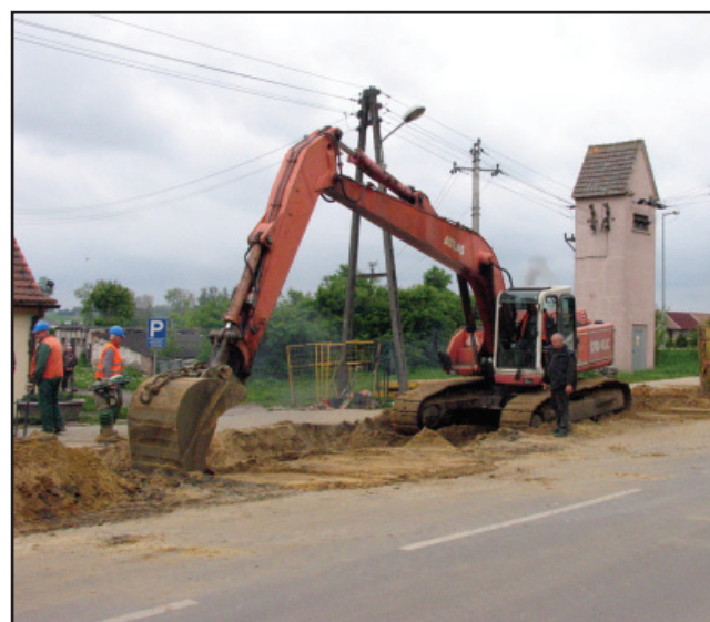
W ramach prac wykonywana jest kanalizacja deszczowa.
