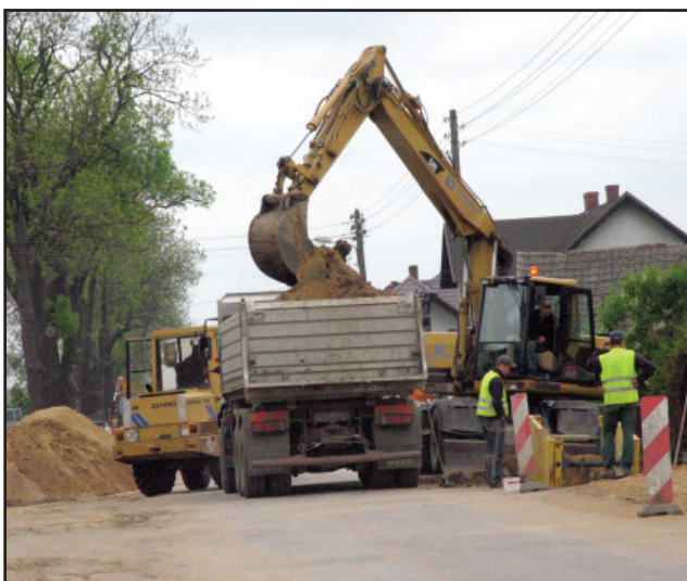
Pierwszy etap prac remontowych jest realizowany w Czacz. bj
