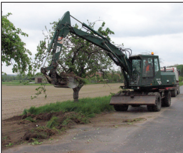
Na drodze z Gryżyny do Krzywinia rowy będą odwodnione, droga zostanie poszerzona.
