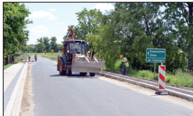
W Starym Gołębinie będą nowe chodniki i nawierzchnia jezdni.
