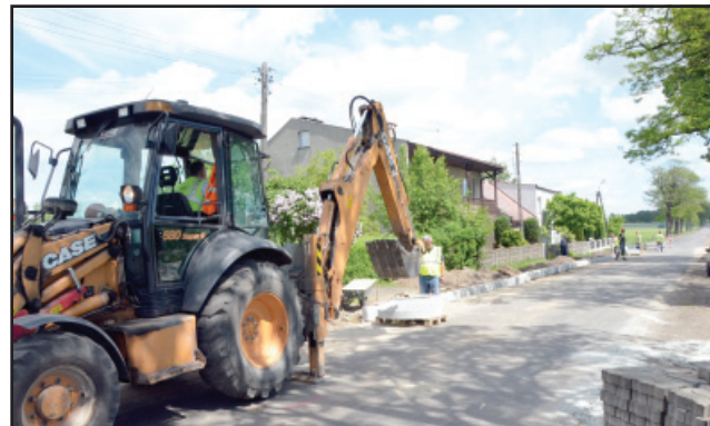
... trwają prace przy układaniu chodnika.
