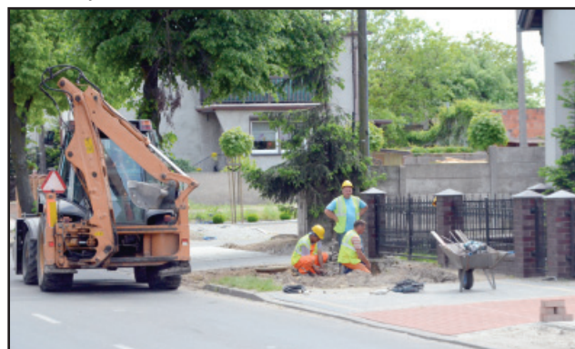
W Nowym Luboszu są remontowane chodniki.
