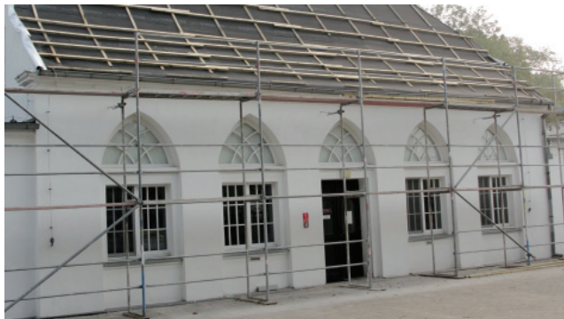
Remont dachu na Domu Ogrodnika w DPS w Jarogniewicach potrwa do końca września
