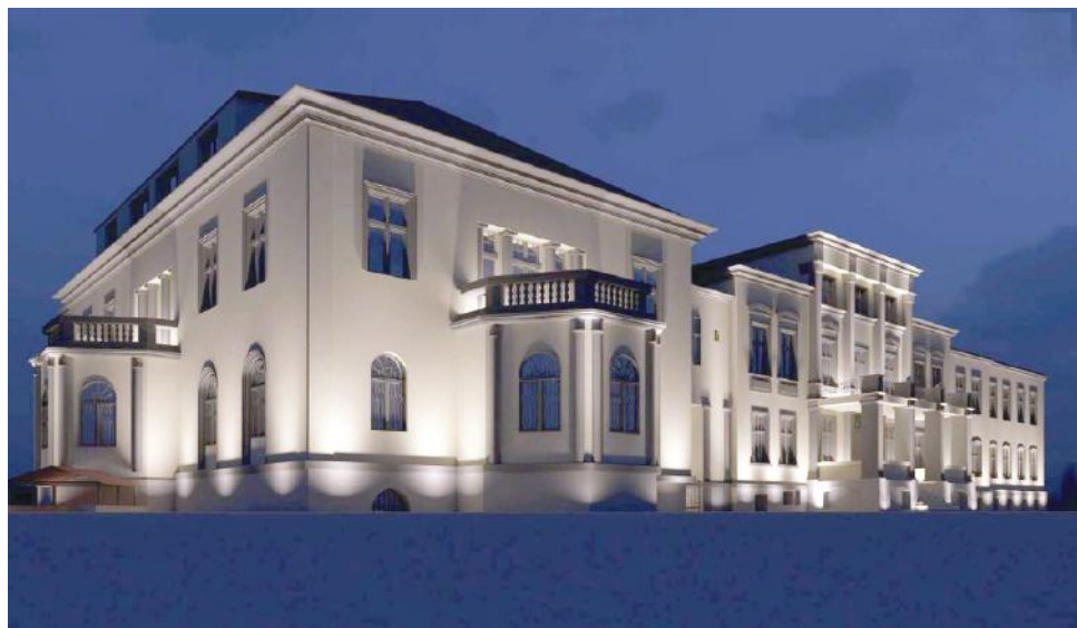
Budynek starostwa i urzędu miasta po remoncie elewacji.
