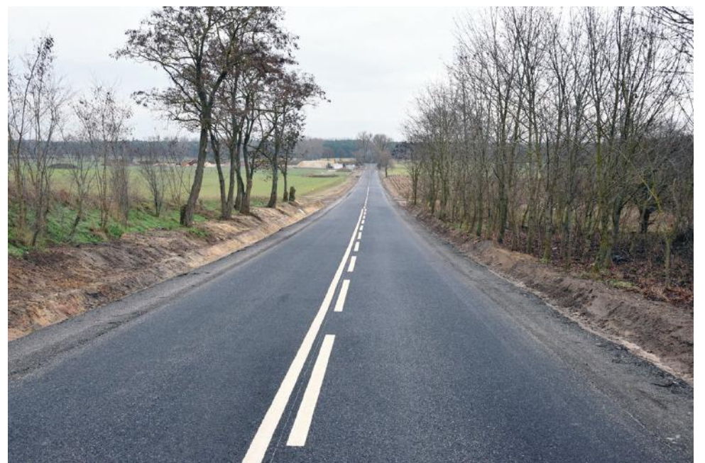
Przebudowa drogi do Srocka Wielkiego została już zakończona.
