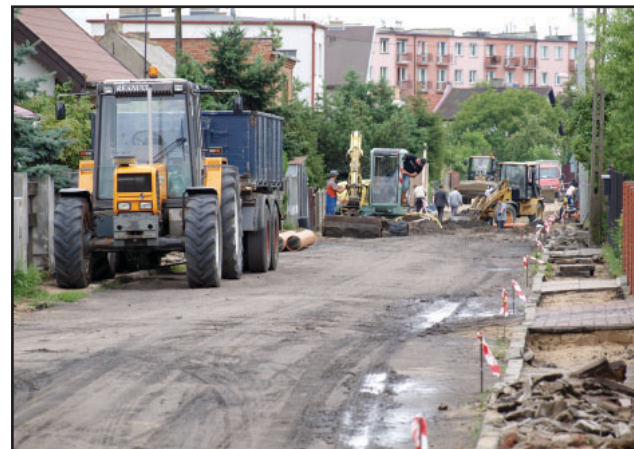
Ul. A. Bukowieckiej jest gruntownie przebudowywana
