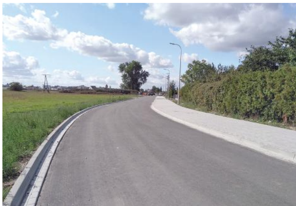
Budowa ul. Polnej w Kielczewie
