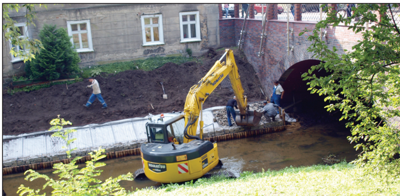
Skarpa przy moście w ul. Wrocławskiej jest wzmocniana palami i gabionami
