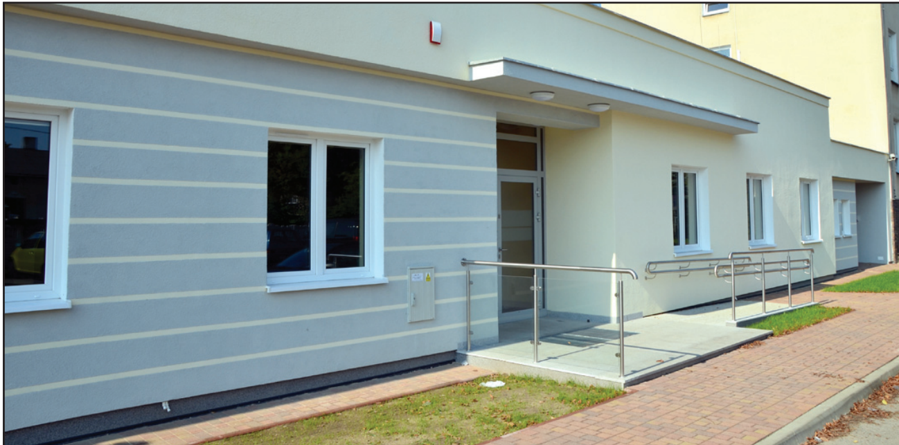
Nowa siedziba PCPR przy ul. Gostyńskiej 38 w Kościanie.
