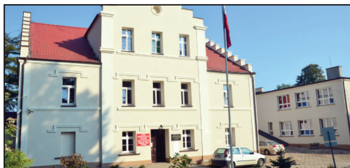
Ocieplono budynki „A” i „B”
