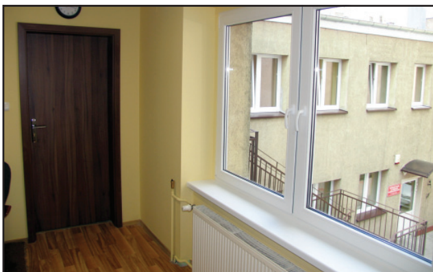
W budynku poradni wymieniono wszystkie okna i drzwi wewnętrzne.
