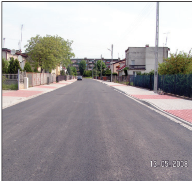
Ul. Kołłątaja podczas budowy
