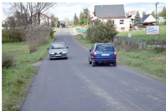
Modernizacja nawierzchni na drodze Sierpowo – Stare Bojanowo na odcinku ponad 2,2 km kosztowała budżet Powiatu blisko 130 tys. złotych.
