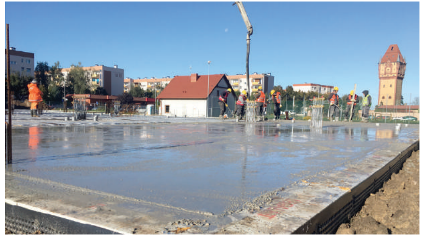
Wykonano już płytę fundamentową nowego przedszkola w technologii pasywnej
