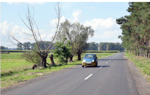
Na całej długości przebudowywanego odcinka położona została nawierzchnia bitumiczna.
