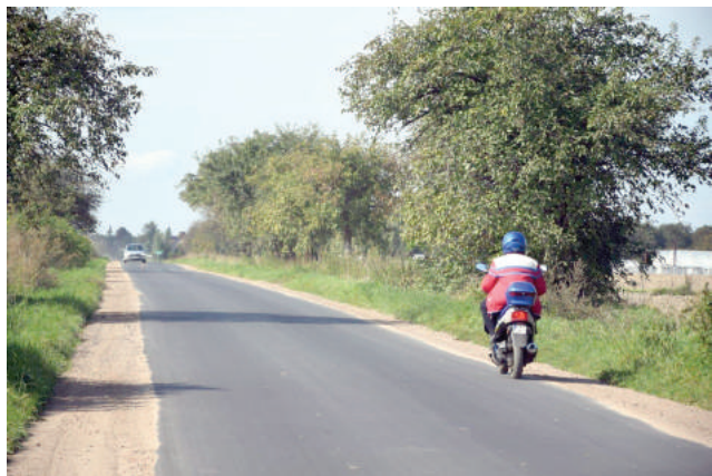
Koszt wyrównania masą bitumiczną drogi na odcinku Karmin – Chelkowo to blisko 109 tys. złotych.
